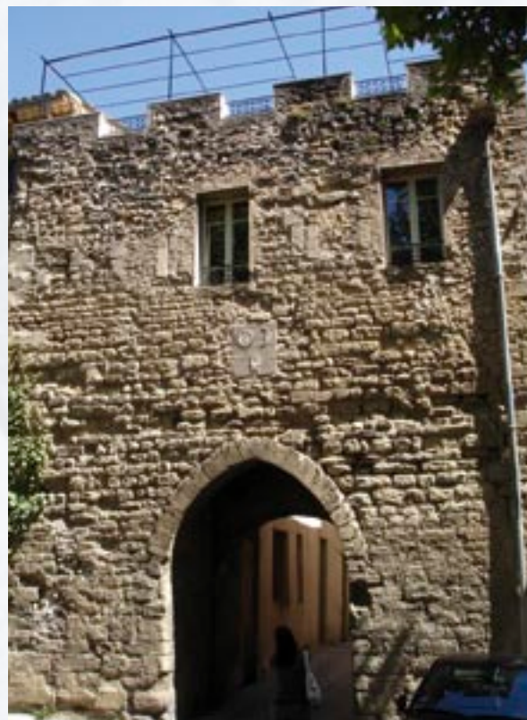
Les portes médiévales seront mises en valeur par un éclairage adapté
