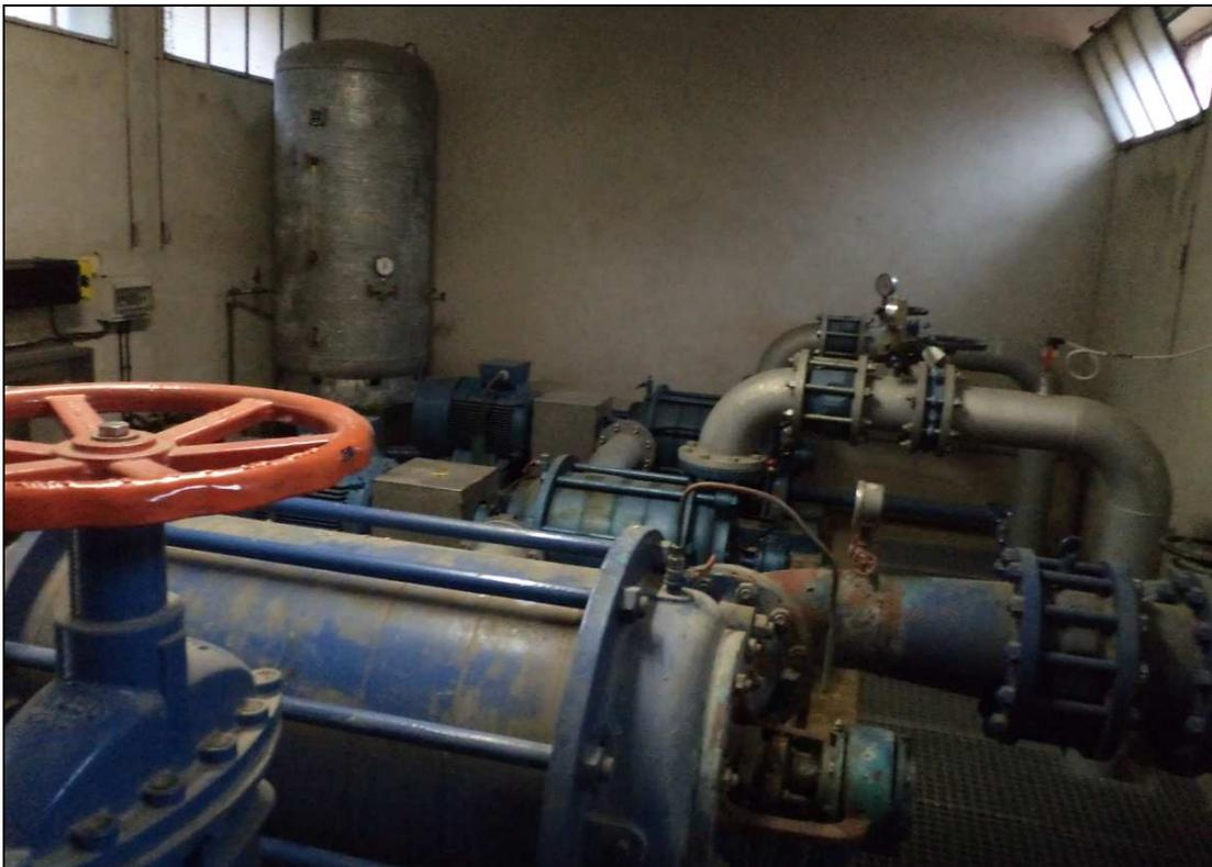
Figure 4-35 : Ensemble des pompes dans la station de La Gardy
