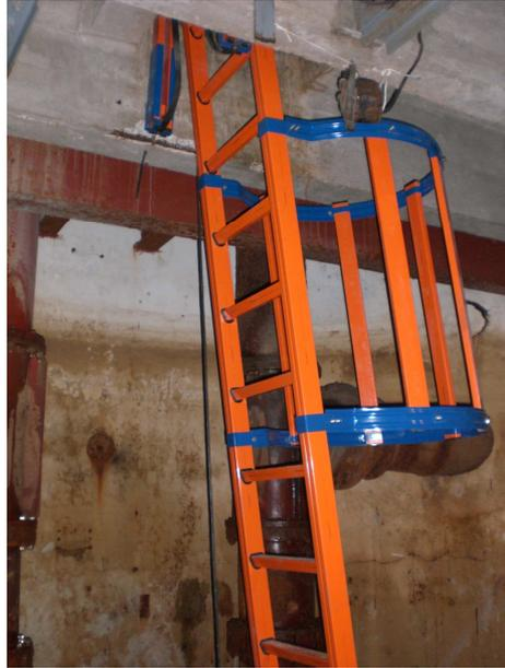
Figure 4-25 : Accès à l'intérieur de la bâche de 300 m<sup>3</sup>
